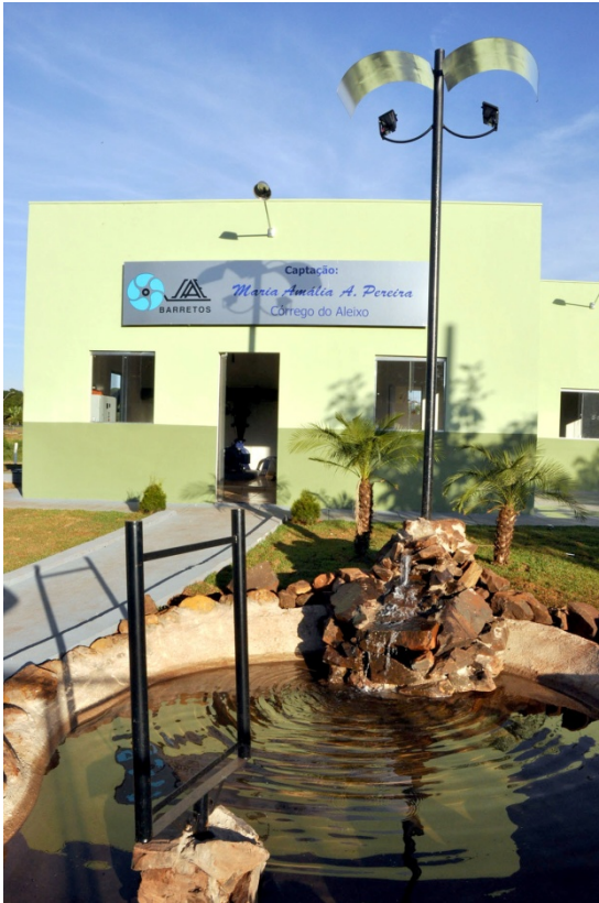
Captação Maria Amália A. Pereira (Córrego do Aleixo) –Reconstruída em 2011
