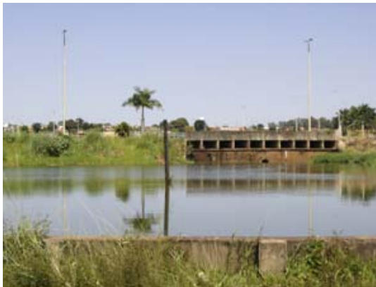
As águas captadas no Córrego do Aleixo são bombeadas à ETA BARONI para serem tratadas e posteriormente distribuídas à população
